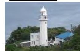
神奈川県 観音埼灯台
