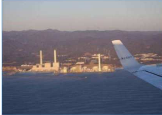
【福島第一原発専用港の航空レーザー測量】
